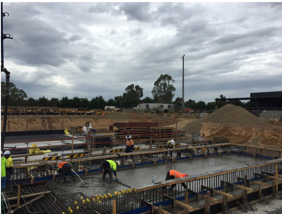
Photo 2: Filtered Water Tank Base Concrete Pour
